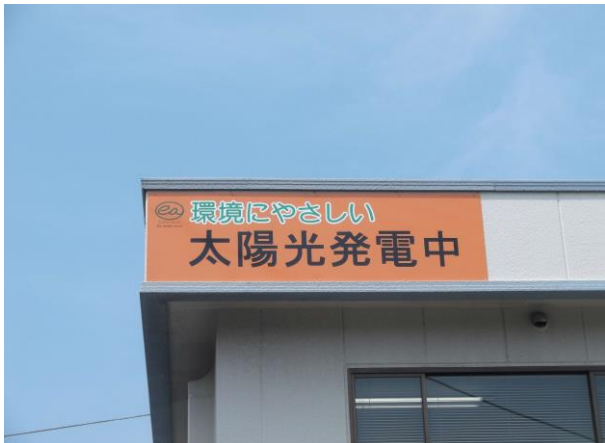
写真3 「太陽光発電中」の看板設置
